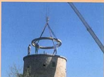
Pose du chemin de roulement
