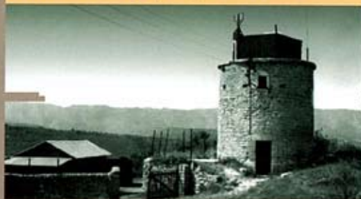
Installations IGN sur le site
