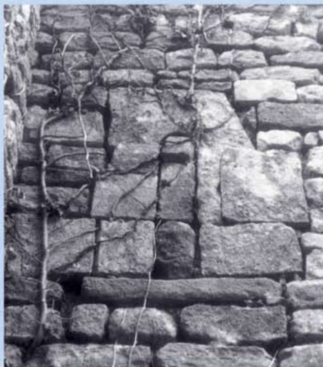
Détail de la fenêtre du mur sud.
