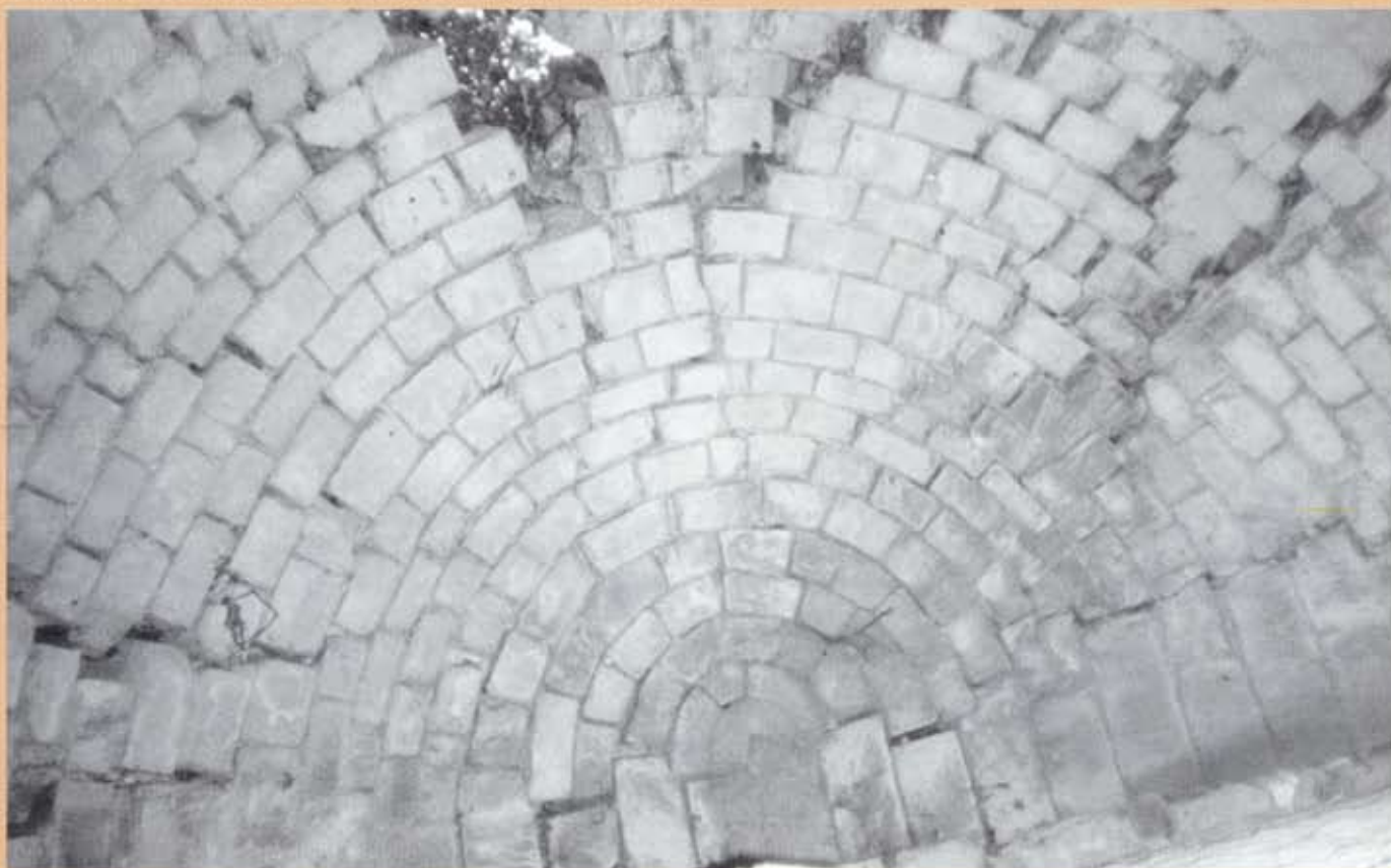
La voûte en cul-de-four, avant les travaux de restauration.
