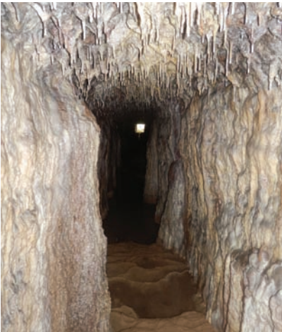
ill. 8 : Vue axiale du couloir de la mine d'eau de Saint-Estève à Ménerbes, depuis l'amont, aux parois très concrétionnées, jusqu'au point de sortie visible tout au fond
