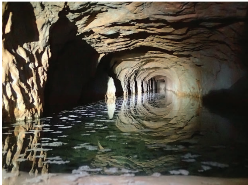
Fig. 4 - Retenue souterraine dans l'aval du réseau de la Gaude (Aix-en Provence)
