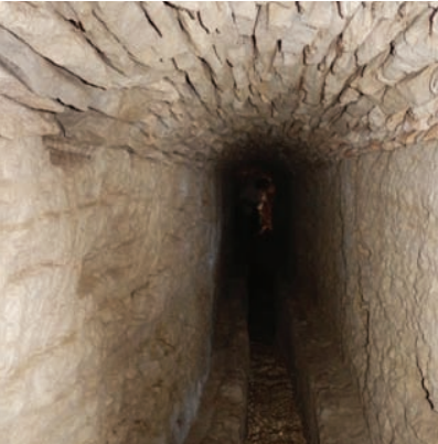
ill. 2 : Galerie active de la mine d'eau filonienne du hameau des Bouillons-Jeannons, Gordes-84
