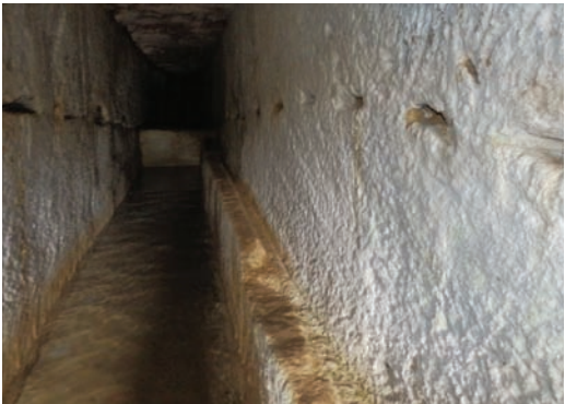
ill. 6 : 1 er tronçon du couloir de mine de Chantebelle creusé par des carriers
