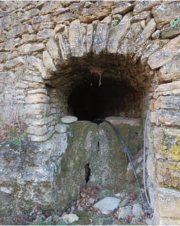
ill. 3 : Barrage construit à la sortie de la petite mine d'eau de Caveiranne, Oppède-84
