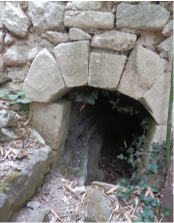
ill. 4 : Issue de la mine d'eau asséchée, située à l'angle du jardin des frères, de l'ancien couvent des Carmes de Saint-Hilaire de Ménerbes-84
